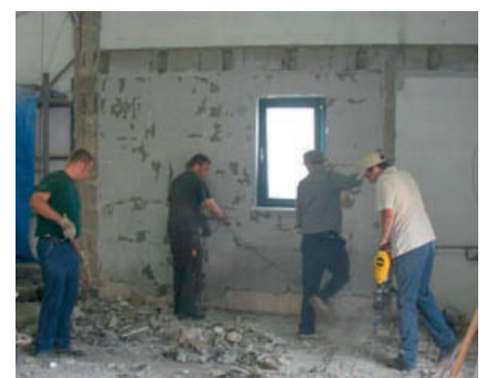
Emsiges Treiben auf der Baustelle.
